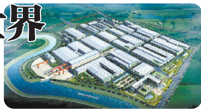
公司EPC总承包的杭氧集团搬迁项目
