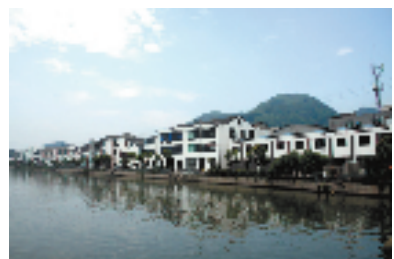
仙岩街道岩一村沿河老房立面改造后一景
