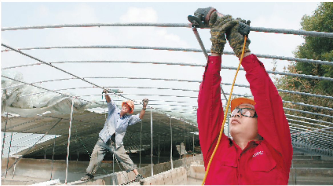
德清县新安镇百富兜村温室甲鱼养殖户姚福生一家,忙着拆除养殖多年的甲鱼棚。
