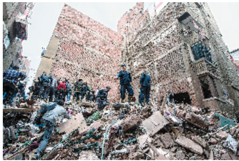
11月25日,在埃及首都开罗,工作人员与当地居民在事故现场搜救幸存者。当日,开罗西郊一栋居民住宅楼25日凌晨突然坍塌,事故造成至少12人丧生、7人受伤。
