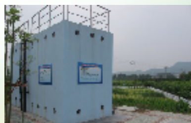
曲池村污水处理终端设施
