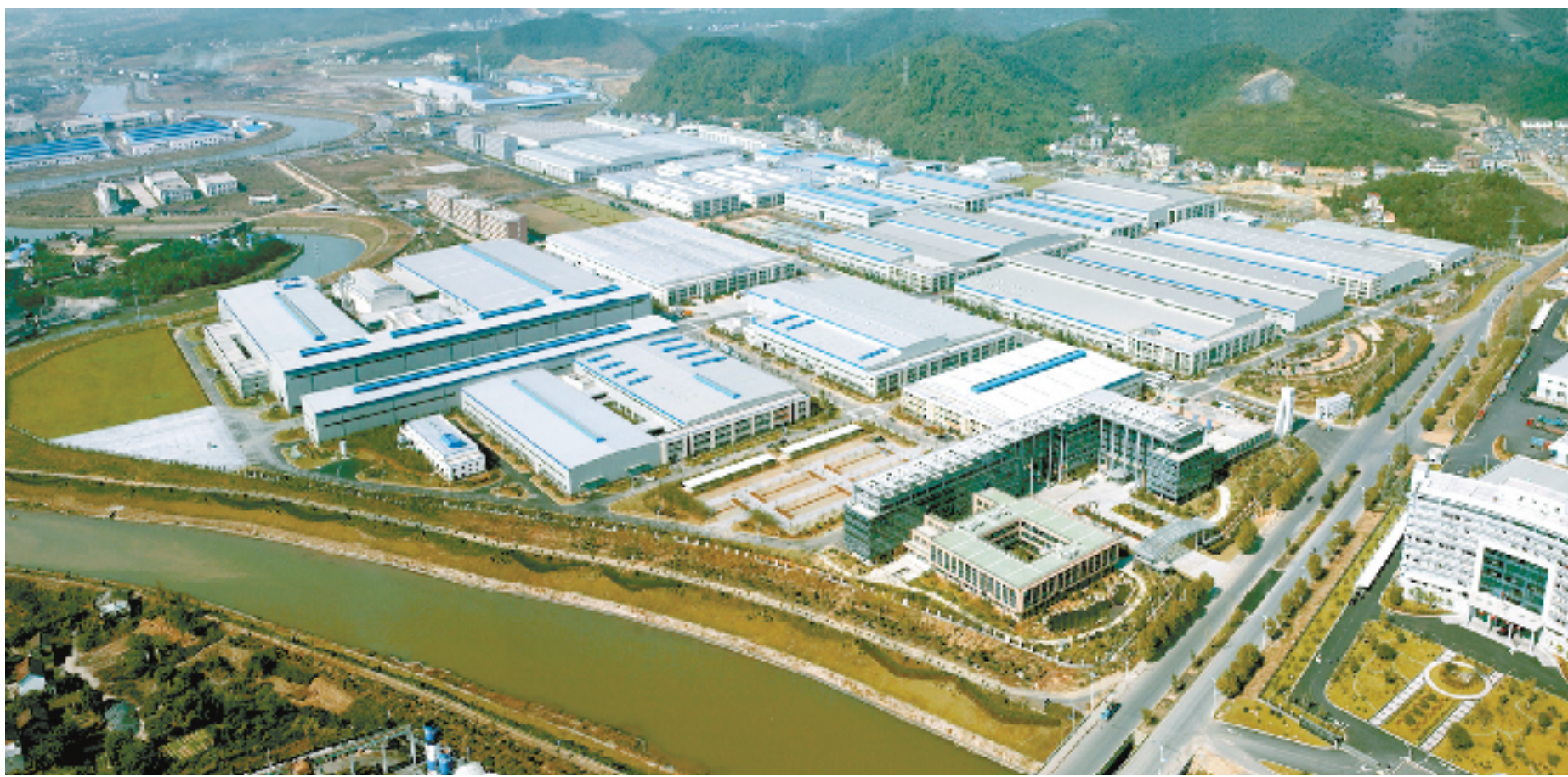
临安青山湖科技城一隅
