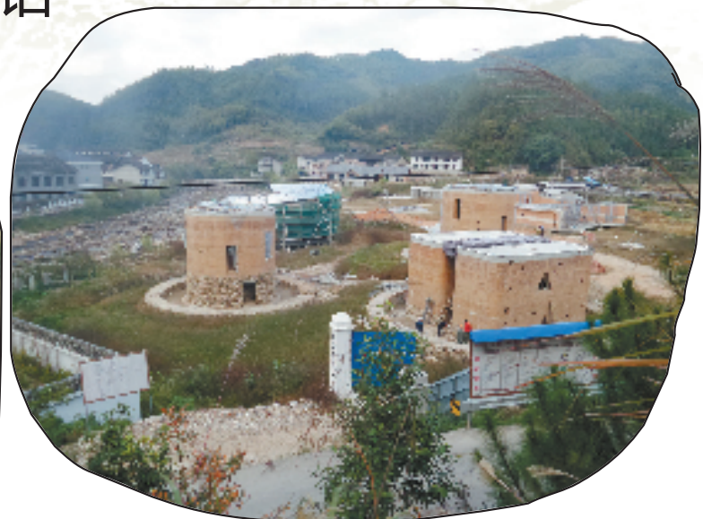
正在建造中的竹建筑,吸引着很多人来参观。
