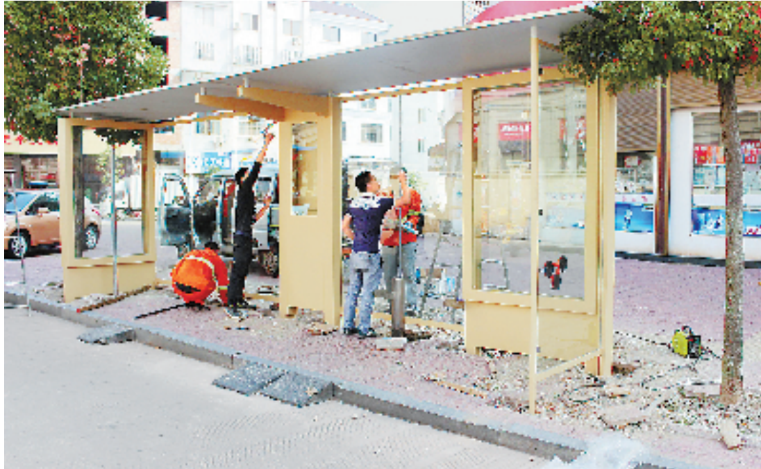
图为正在改造的公交车停靠站。
