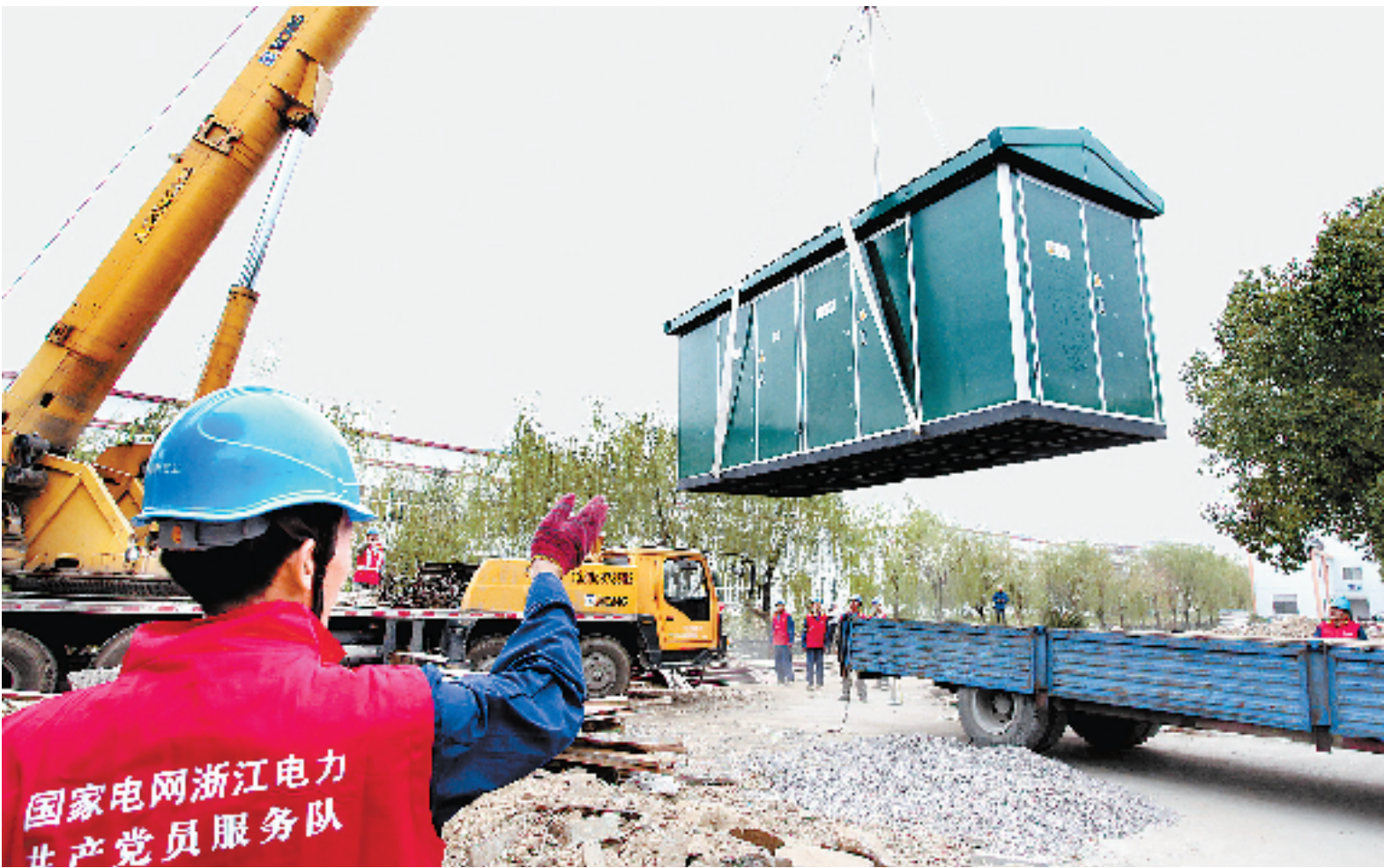
10月30日,在宁波市鄞州新城区,工人在无轨电车充电站点安装箱式变电站。鄞州新城区正在建设一条储能式无轨电车示范线,全长10.2公里,共设14座公交车站。 胡建华 黄备 郑之超 摄
