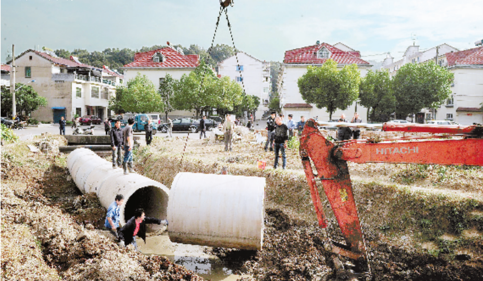
图为10月29日,武义县熟溪街道江山新村老旧小区改造现场开始建设雨污分流管道。武义县投资约1600万元,对老旧小区进行环境整治和提升改造,新建地下排水管网和燃气管道。 张建成 摄
