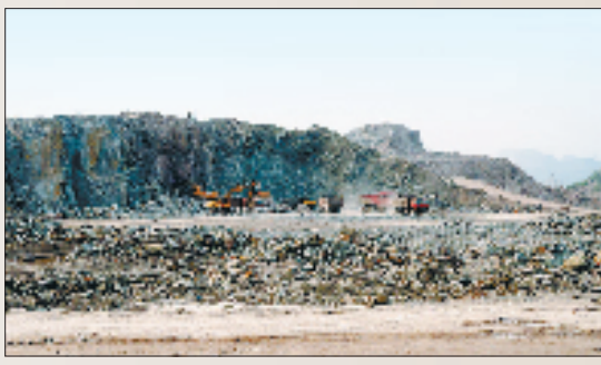
丽水低丘缓坡施工现场
