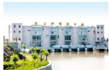
完工并投入使用的四工段排涝闸
