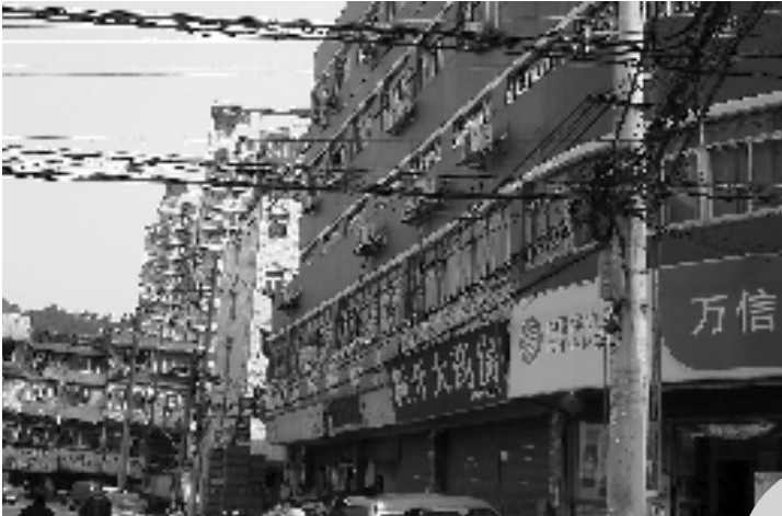
改造前的黎明92,杂乱的电线和违法建筑物随处可见。
