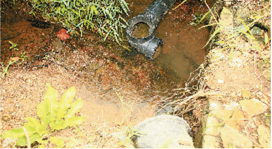
湖底村生态污水处理系统中,污水管并未和处理池连接。
