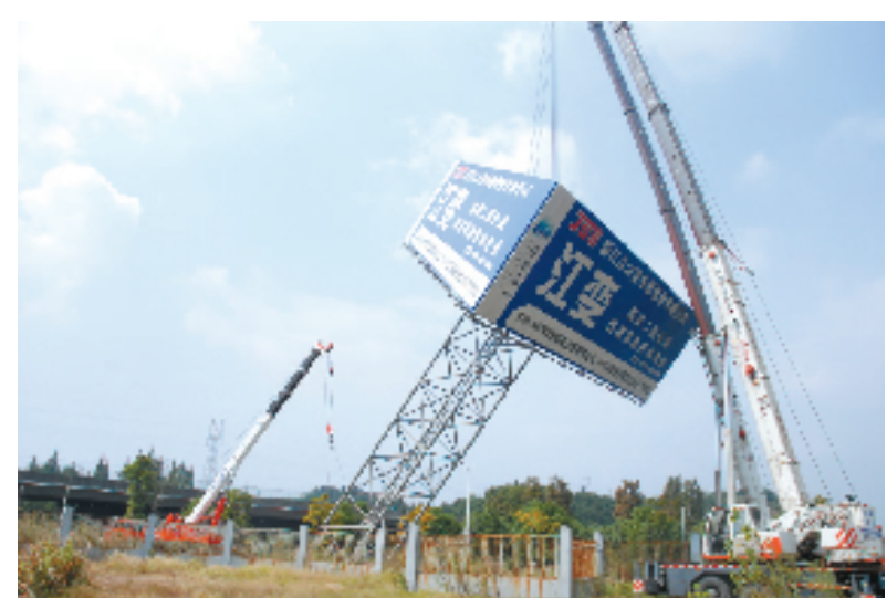
江山公路边违法广告一律下架拆除 毛建华 摄
