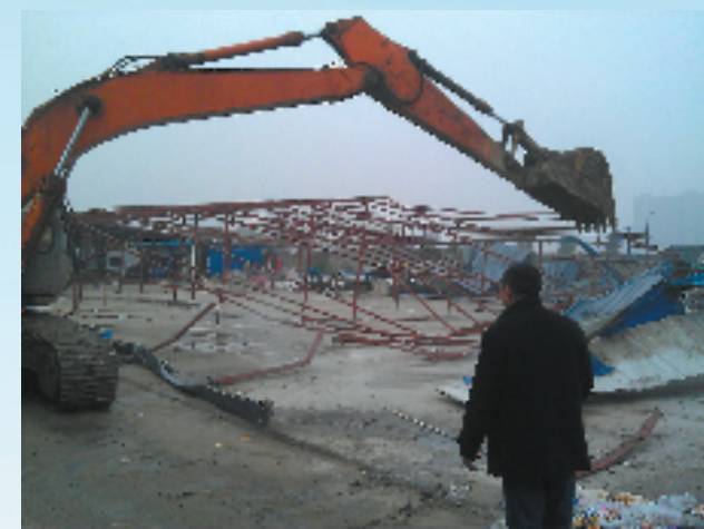
杭州经济技术开发区明望蔬菜批发市场内违建拆除现场
