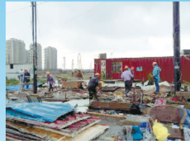
江干区杨江岸临时菜场拆除现场
