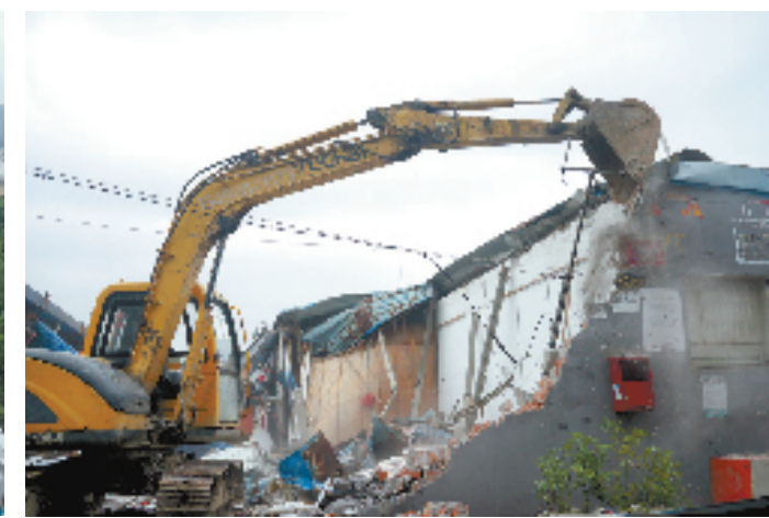
萧山育才路夜市拆除现场
