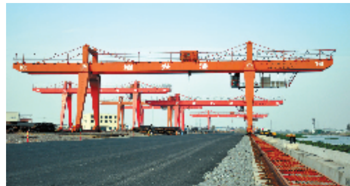
绍兴港现代物流园项目
