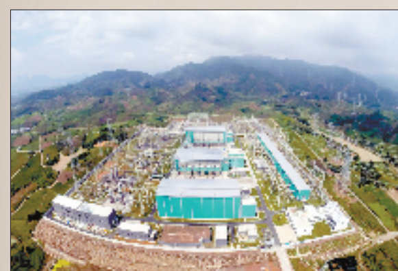
特高压金华换流站
