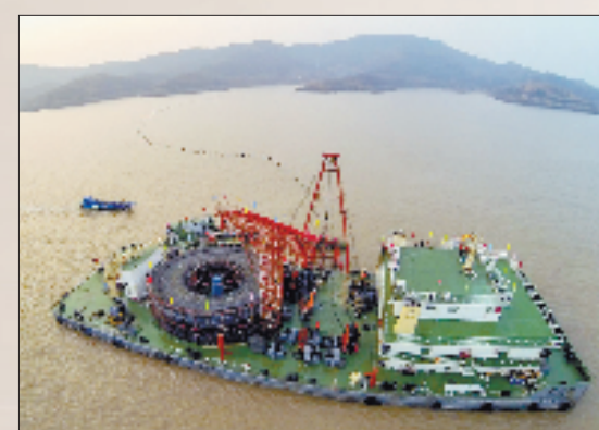
舟山柔性直流输电工程正在进行海底铺设
