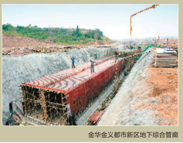
金华金义都市新区地下综合管廊
