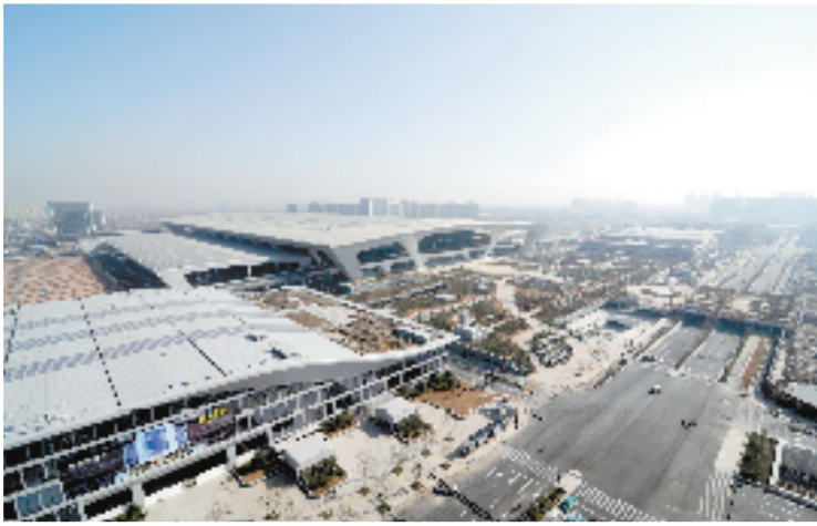
气势恢宏的杭州火车站枢纽地下空间也得到充分开发
