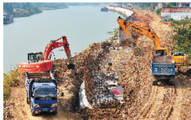
长兴县虹星桥镇港口村的苕溪清水入湖河道整治工程现场,施工人员进行抓紧施工。工程建成后,防洪能力达到50年一遇。 叶赛青 谭云俸 丁珊 摄
