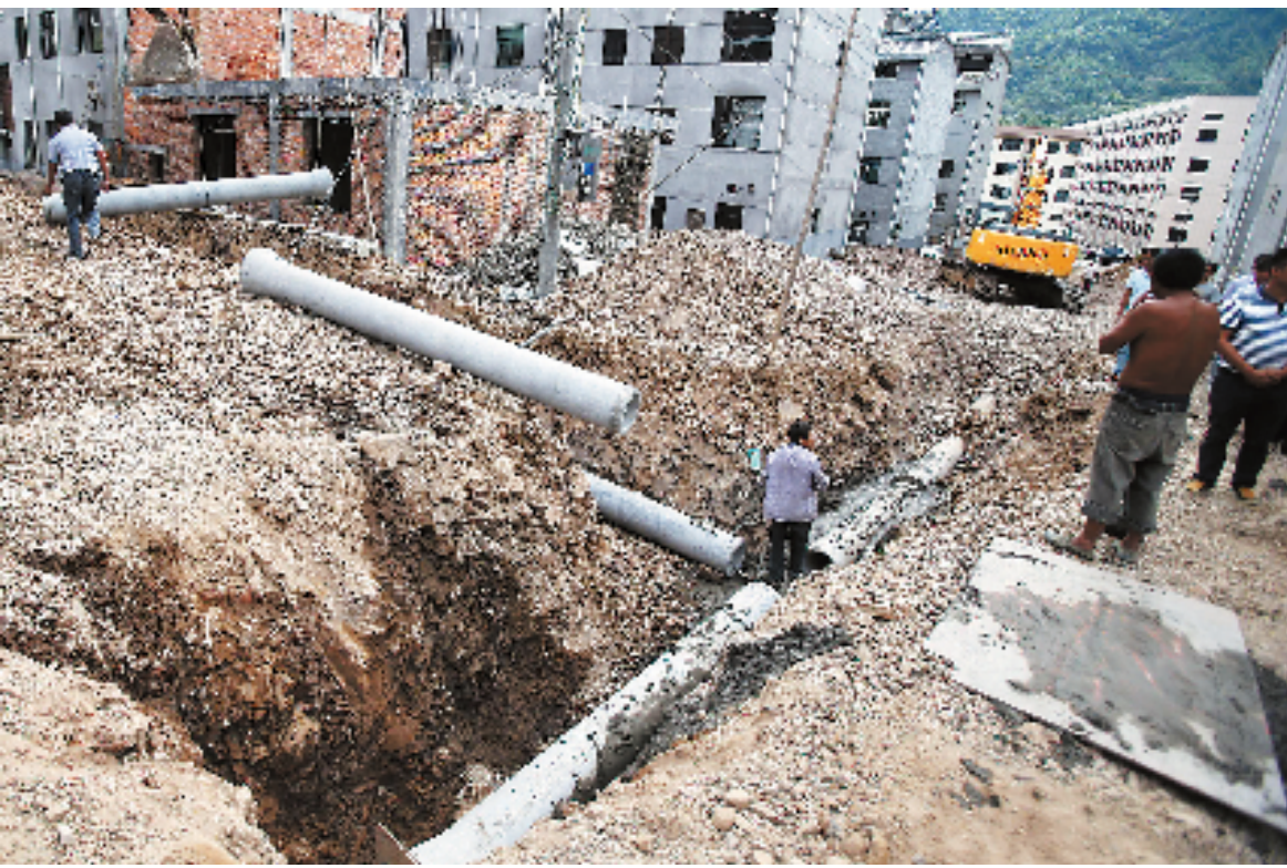
上图:近日,磐安县尖山污水处理厂投入运行。 下图:磐安尖山镇23个村,村村铺起下水管道。
