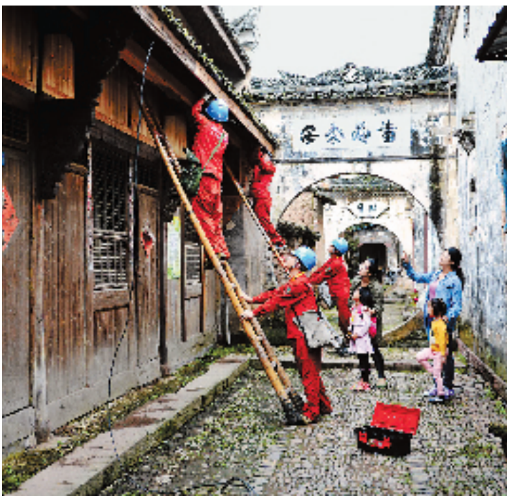
秋高气爽,丽水各农家乐等生态休闲旅游景点都迎来了游客高峰。国网丽水供电公司组织党员服务队加大对全市各旅游景点、农家乐等的巡防力度,确保景区及农家乐的电力设备和线路完好。图为上月底,丽水供电公司组织党员服务队对缙云县新建镇河阳古民居的老旧线路进行更换。
