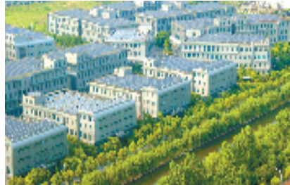
全省首个2兆瓦屋顶太阳能发电装置
