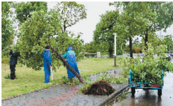
在定海新城,工人们正给被大风吹倒的绿化树枝修剪,待风力减小后再把树木扶正。 张磊 摄
