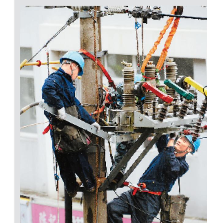
9月23日,舟山电力工人在更换受损电路开关。姚峰 王文波 严朝晖 摄
