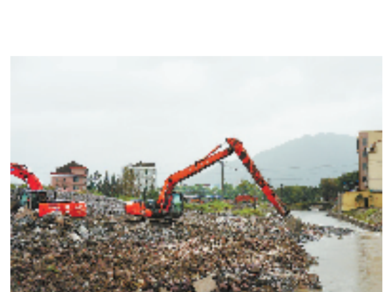
临海市区通往下游的一条主要排洪河道被泥石严重堵塞,当地政府迅速调派人员、大型机械,连夜对河道进行疏通。斯信忠 陈耿 摄
