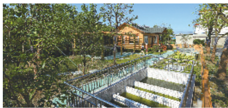
新建的河庄街道农村生活污水治理试验区
