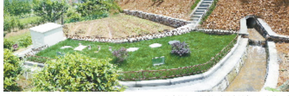
街亭镇新毛家村新建的农村生活污水治理池
