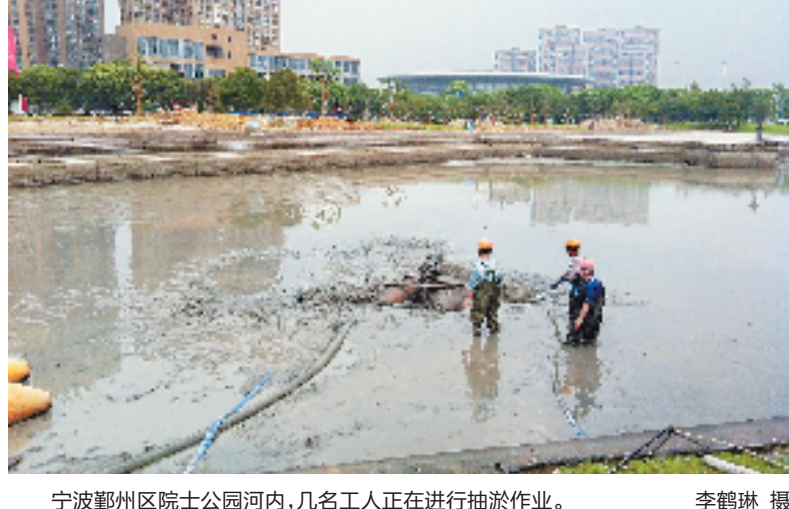
宁波鄞州区院士公园河内,几名工人正在进行抽淤作业。
