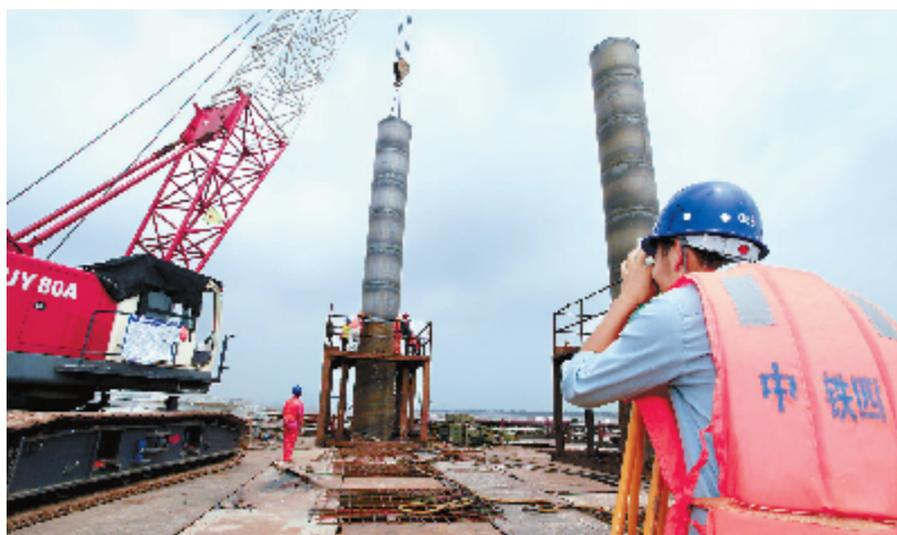
温州市域铁路灵昆特大桥桩基施工。
