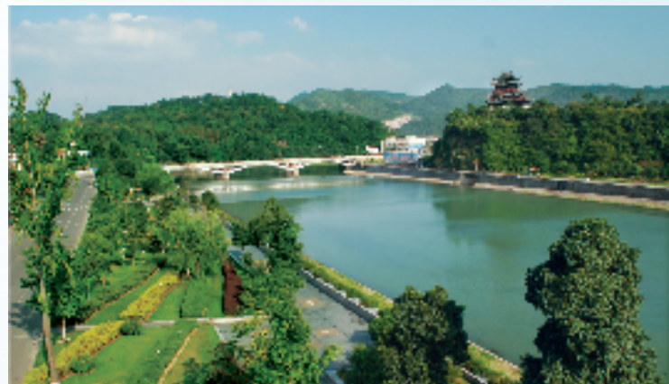
整治后的洋溪流域
