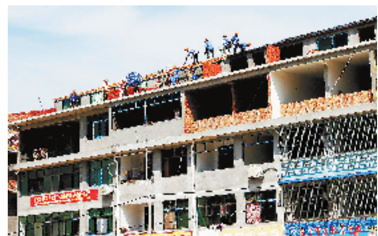
8月28日,景宁县城东郊店面房在拆除违建。这个地段是居民安置点,楼高四层,一些居民为了增加住房面积,在顶层违建了阁楼,当天共拆除违建2000余平方米。楼欣建 摄
