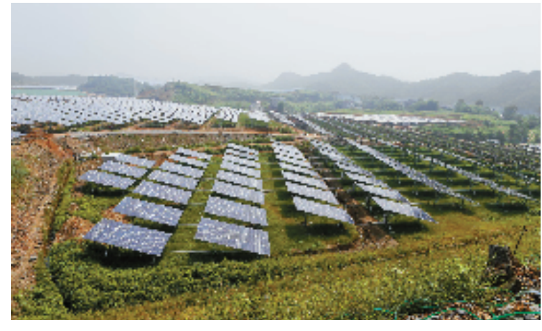
8月27日,江山市凤林镇株树村,30兆峰瓦大型跟踪式农光互补光伏电站项目正在扫尾。该项目集光伏发电、珍稀名贵中药材种植、观光科教于一体,投产后可实现年发电量4000万千瓦时,节约国家标煤1.3万余吨。邵全海 郑积亮 余静涛 摄
